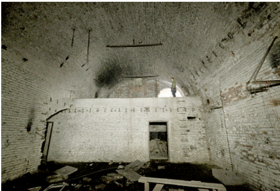
„Unterirdische Bauten“, Teilbereich des Brauereikellers St. Marx. Foto: Thomas Keplinger
